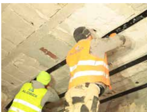
Klejenie taśm węglowych FRP
